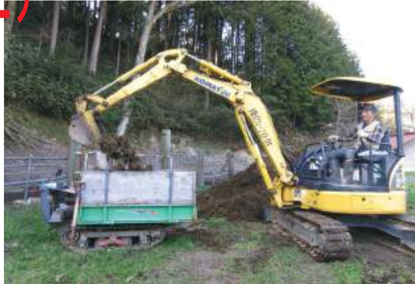
積み込みはパワーシャベル(リース)
