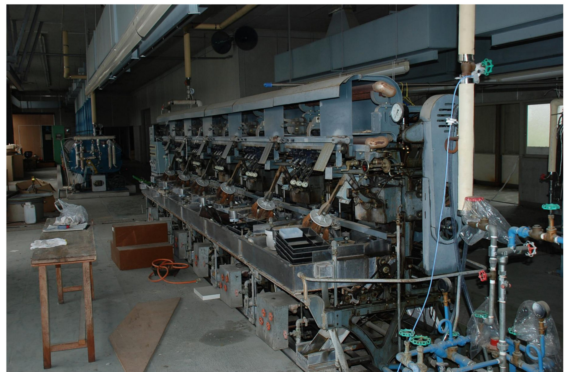
旧鳥取県繭検定所(米子市旗ヶ崎)の製糸機械 —山陰製糸業の産業遺産—
